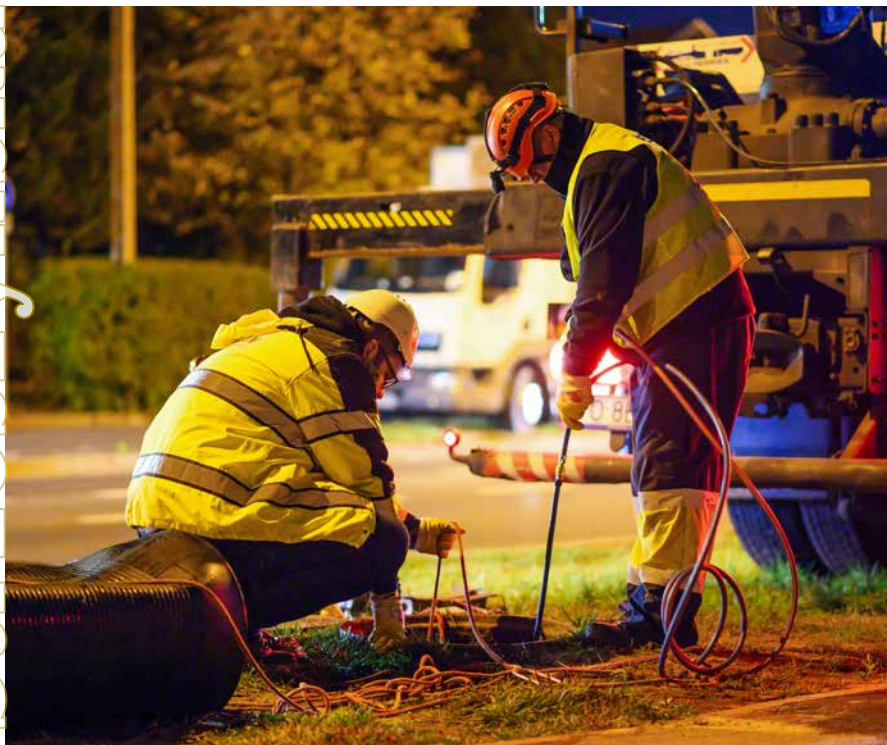
Renowacja sieci rękawami z włókna szklanego – technologia wykładzin CIPP, utwardzanych gorącą parą.
