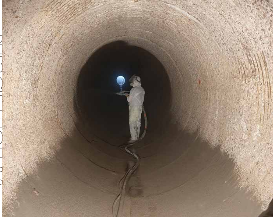
Skanowanie 3D kanalizacji deszczowej.
