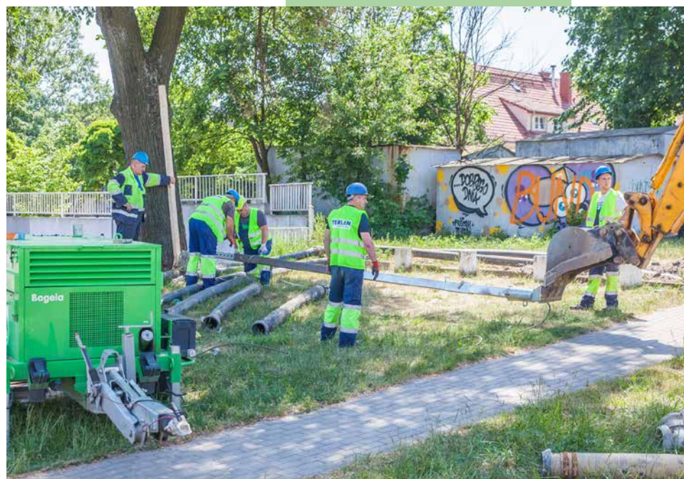
Renowacja kanalizacji modułami GRP.
