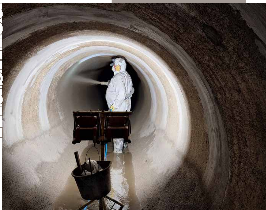
Renowacja za pomocą natrysków cementowo-polimerowych PCC.
