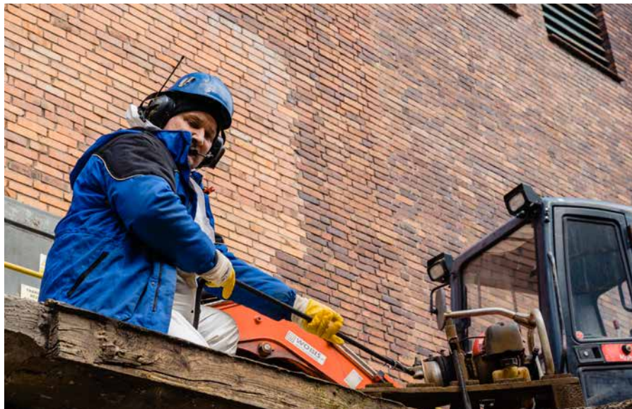
Renowacja magistrali wody chłodzącej DN1200 technologią COVERLAN w Elektrowni Błachownia w Kędzierzynie Koźlu.
